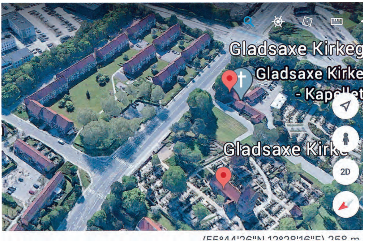
Ved Kirken- bemærk byggeriets hilsen til kirken med de røde tegltage. Smukt harmonisk byggeri., Gladsaxe
