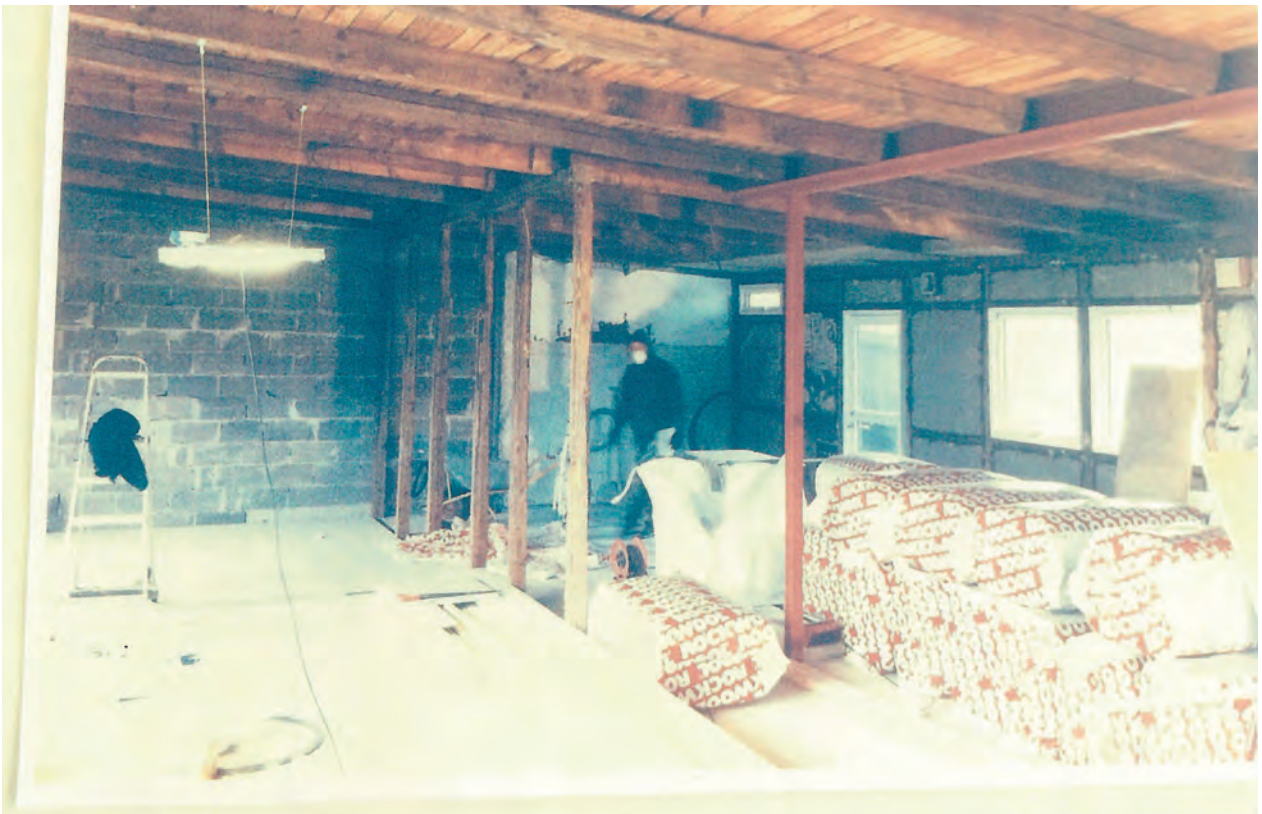
Et Christiansgave-hus under opførelse, bemærk der ikke anvendes murere.
