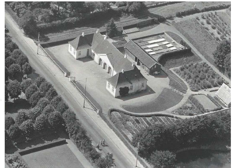
Christiansgaves nyttethave, portnerbygning mv. på vestsiden af Strandvejen i Rungsted, set fra luften i 1937.
